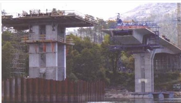
EN PROCESO DE CONSTRUCCIÓN
