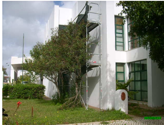
Montagem de Andimes
