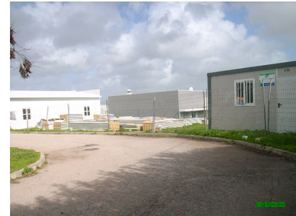
Montagem de Estaleiro
