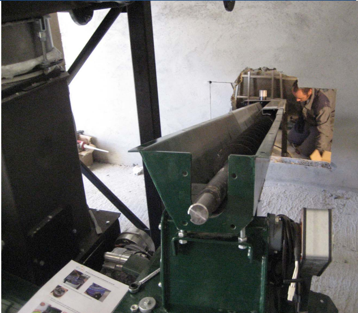
Instalación del sistema de alimentación automática (tornillo sin fin)
