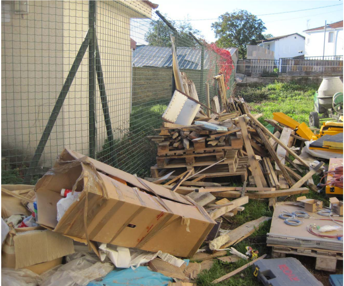
Pallets y cajas procedentes de la obra, acumulada en los alrededores
