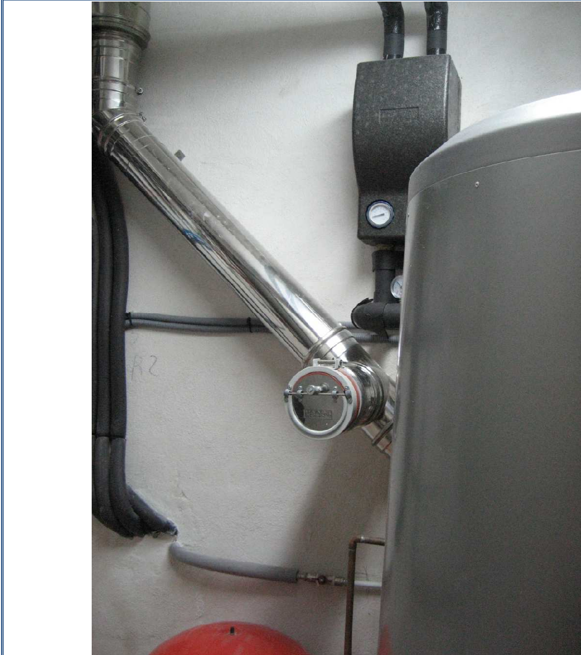
Interior de Sala de Calderas. Detalle
