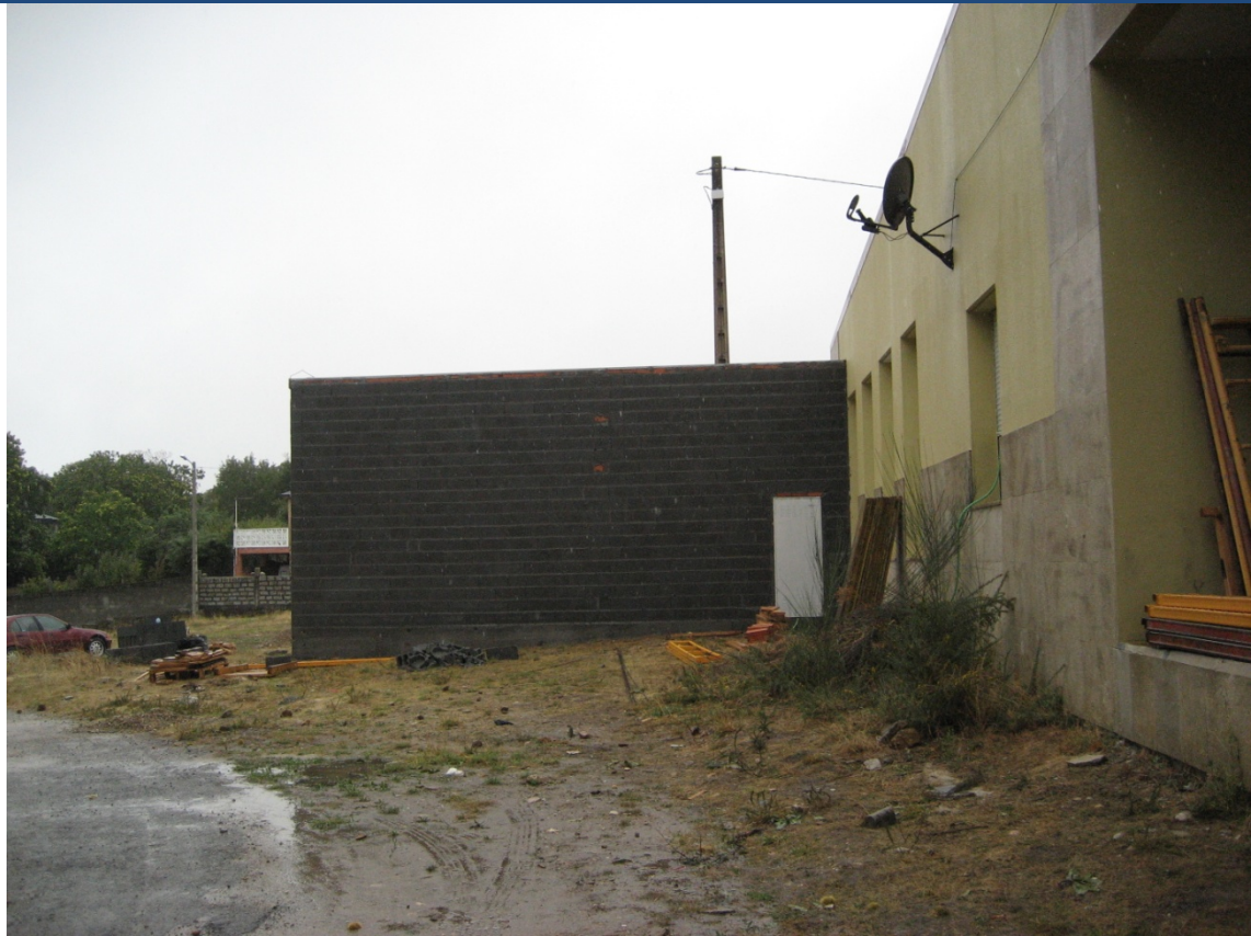
Construcción del silo anexo al edificio multiusos.
