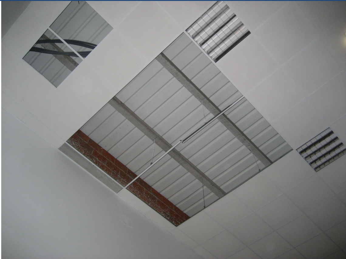
Detalle de la cubierta del edificio
