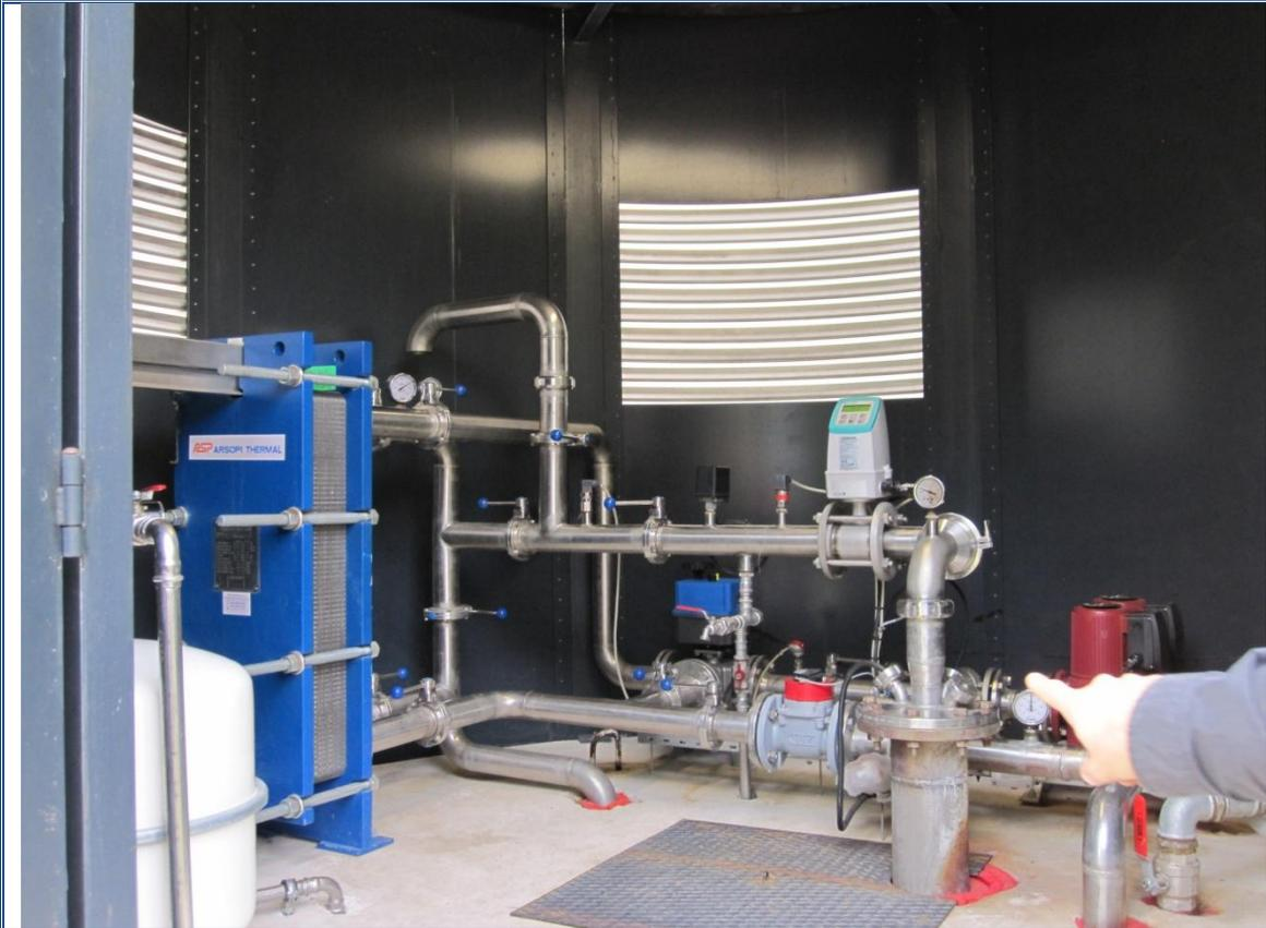
Interior de la caseta que alberga la instalaciones de la captación AC2. Señalando conexión entre el tubo de captación y el sistema de intercambio.
