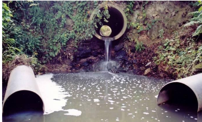
Fig. 26 – Descarga de efluentes líquidos para um rio.
