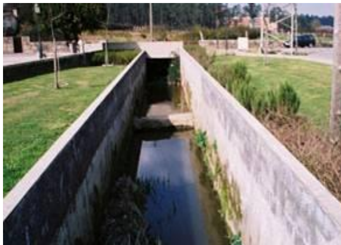
Fig. 23 – Canalização de uma ribeira.
