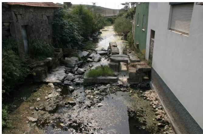
Fig. 24 – Urbanização das margens do rio.
