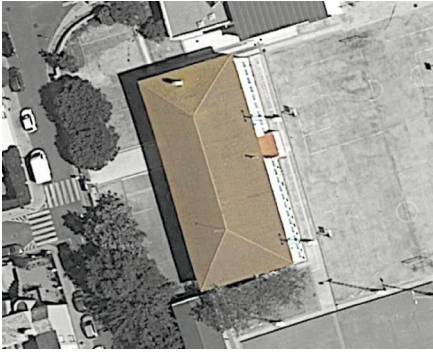
Figura 30. Clasificación volumétrica. Colegio S013. Edificio: 1. Tipo: prisma.
