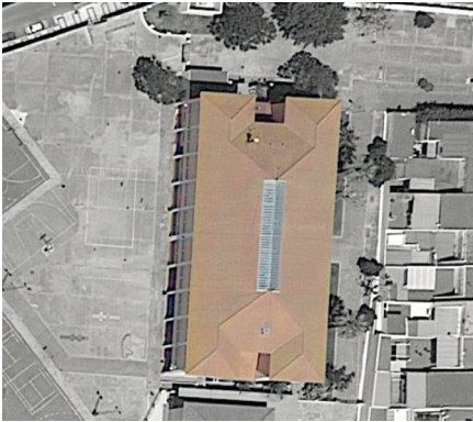
Figura 14. Clasificación volumétrica. Colegio S006. Edificio: 1. Tipo: compacto. Subtipo: forma de H.
